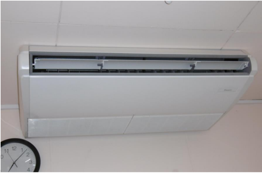
作業場空調設備工事
