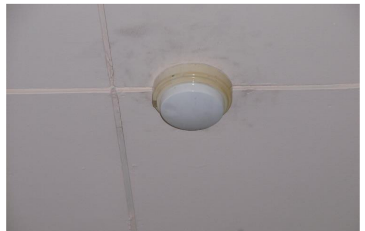
感知器増設工事
