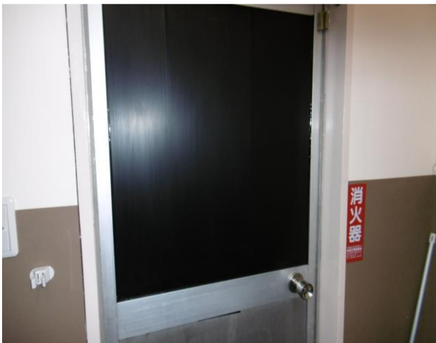
遮光工事(一部)
