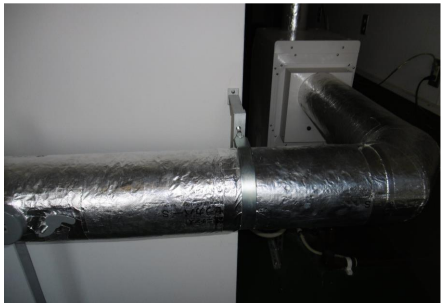
保管庫精密空調設備工事
